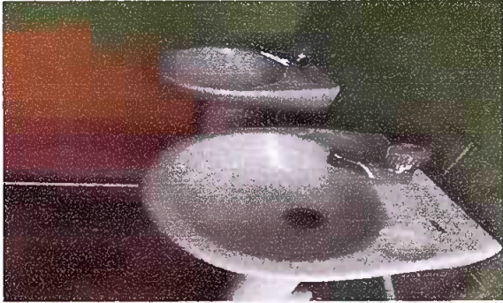
FOTO 1 SUSTITUCION DE LAVA MANOS CAMBIADO
