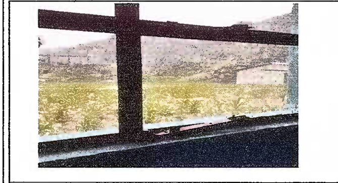
Foto: 7 SUSTITUCION DE VIDRIOS CAMBIADO
